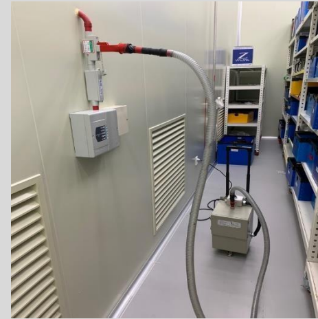
3W SUCTION KIT을 사용한 유지보수
